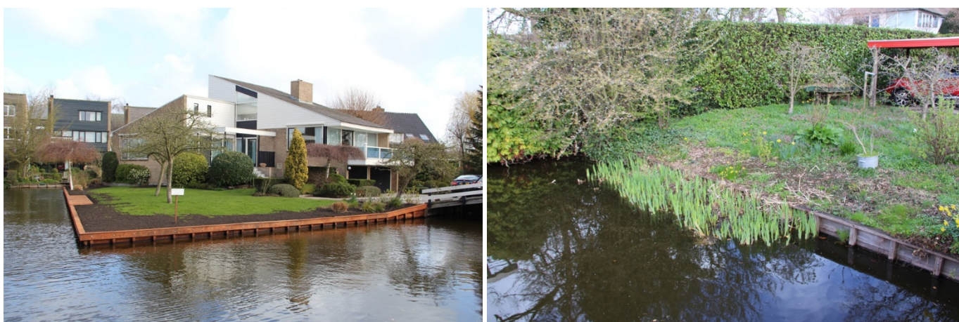
Figuur 8. Veel tuinen in het Reeuwijkse Plassengebied zijn voorzien van een harde oeverbeschoeiing om de stabiliteit van de tuin en het huis te garanderen. Om toch de harde gradiënt iets te verzachten kan men, zoals de foto links laat zien oeverplanten aanbrengen voor de harde damwand. Bij voorkeur oeverplanten die bloeien en waarop wilde bijen kunnen foerageren. Als iedereen dit binnen de Reeuwijkse Plassen voor zijn of haar harde damwand uitvoert, dan vormen de vele meters oeverplanten een aantrekkelijke voedselbron voor wilde bijen en vele andere insecten soorten.
